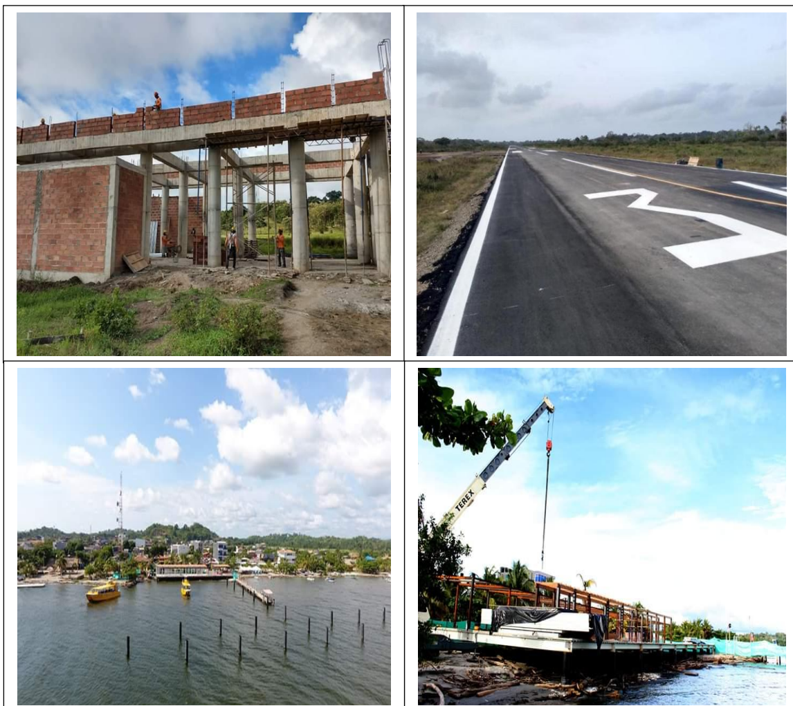
Figura 9. Obras de infraestructura en Necoclí Fuente: Alcaldía de Necoclí, (2019).
