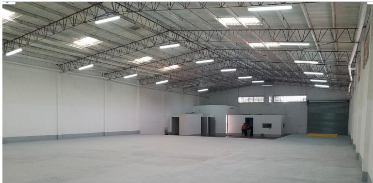
Imagen N°2 – Perspectiva interna de nave industrial desde área de producción a rentar.
