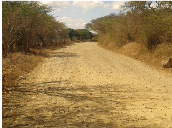
Ilustración N°4: Estado del camino Empalme El Regadío - Puente Gualilica.
