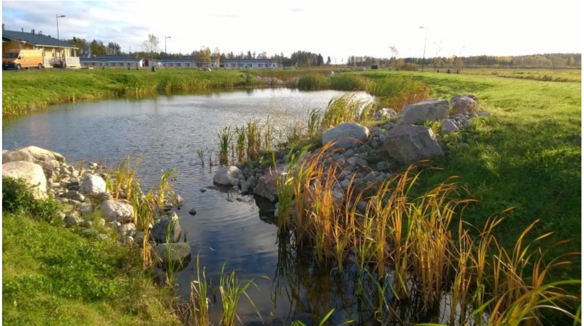
Kuva 2.3: Aallottarenpuiston hulevesiallas Järvenpäässä (Järvenpään kaupunki 2019)
