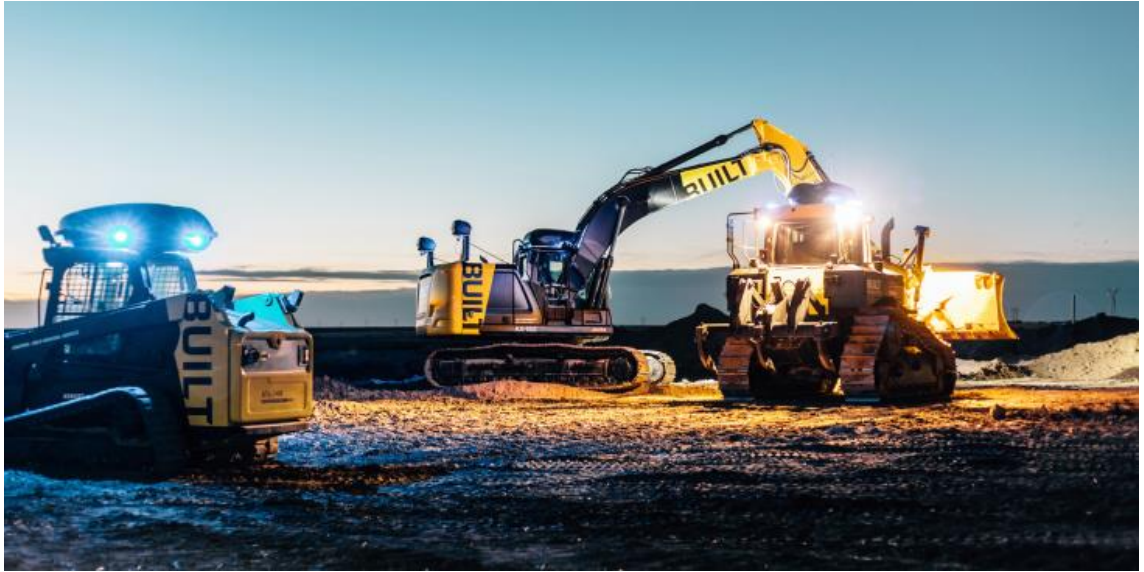
Kuva 17. Built Roboticsin laitteisto lisätty tavallisiin maansiirtokoneisiin. (Built Robotics 2019)
