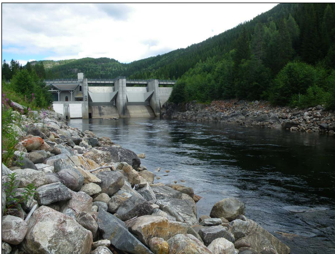
Älvkraftverk och kanalisering – vilken effekt kan de ha på flodpärlmusslan? Denna problemställning är undersökt i Begna i samband med Eid kraftverket. Foto: Bjørn Mejdell Larsen.
