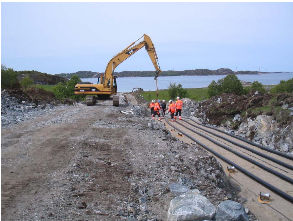
Figur 23. Kabling av høyspentledninger krever store naturinngrep. De enkelte faselederne må ligge med god avstand og grøftene blir slik sett brede. I tillegg må det opparbeides atkomstvei langs kabelgrøftene for å sikre tilgang for vedlikehold og reparasjon. Foto: Statnett.
