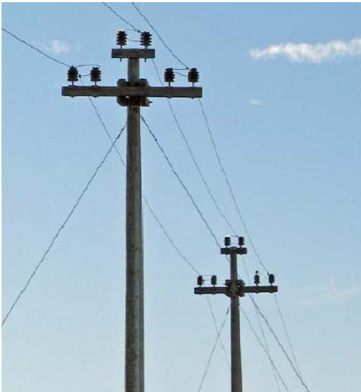
Figur 15. En flat konfigurasjon er å foretrekke fremfor trekantoppheng slik som bildet viser – mye tyder på at kollisjonsfaren noen steder reduseres proporsjonalt med reduksjon i antall "etasjer" med ledninger. Foto Kjetil Bevanger.
