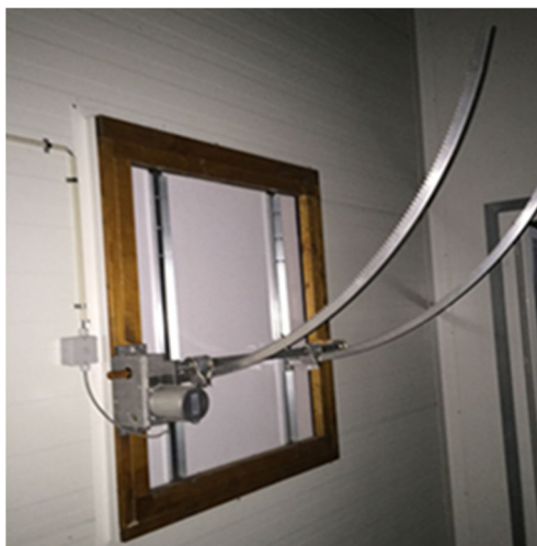
Figur 60. Automatisk spjeld for innslipp av uteluft
