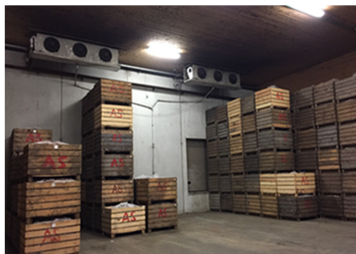
Figur 56. Prinsippkisse av et kuldesystem (t.v.) og plassering av fordampers i tradisjonelt omluftslager (t.h.)
