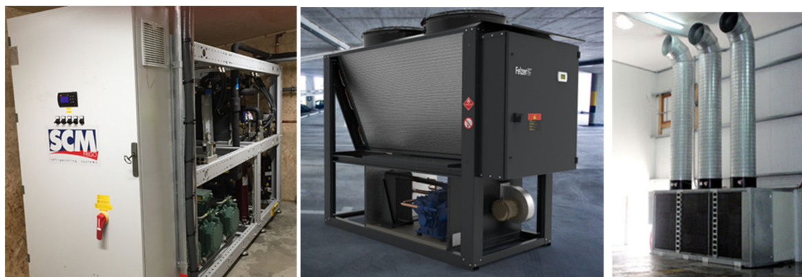
Figur 58. Aktuelle miljøvennlige kuldesystem: CO 2 (t.v.), propan (midten) og R1234ze (t.h.) Foto: SINTEF, Felzer og Grimme AS.
