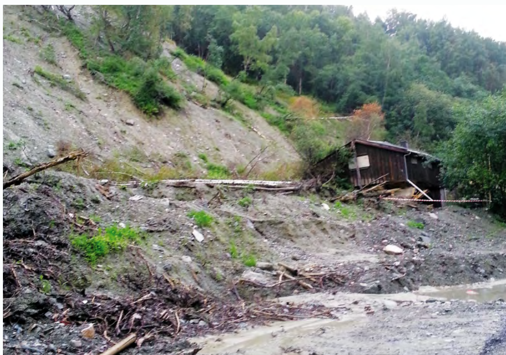
Løsmasseskred utløst av kraftig nedbør, Kvam i Nord-Fron kommune. Skredet har flyttet huset omtrent halvannen meter ut fra grunnmuren. Foto: SINTEF/Byggforskserien
