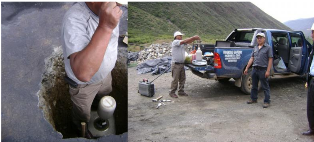
Foto n° 03 y 04 Trabajos Excavación de Calicatas en la Área de la Molienda
