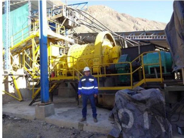
Imagen n°15 Vista de la Estructura.
