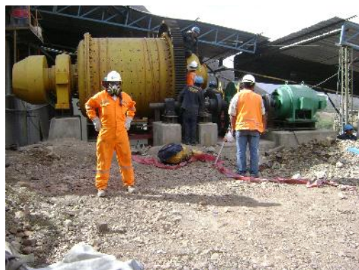
Imagen n°16 Vista de los Pedestales de la Estructura.
