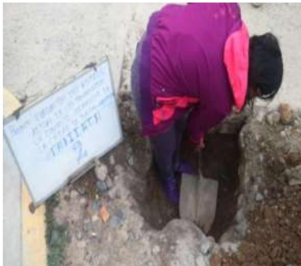
**Imagen. 04** se observa realizando la excavación para la extracción de la muestra de la calicata 02
