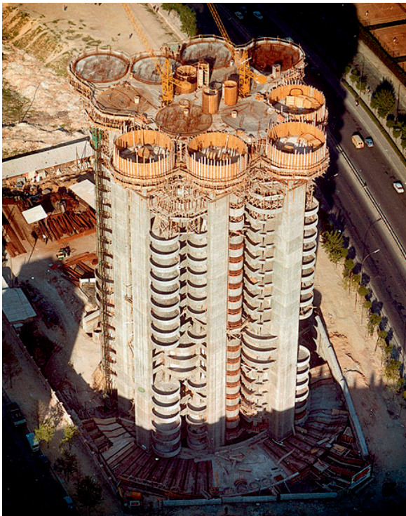
Torres Blancas in aanbouw, 1967 Torres Blancas under construction, 1967
