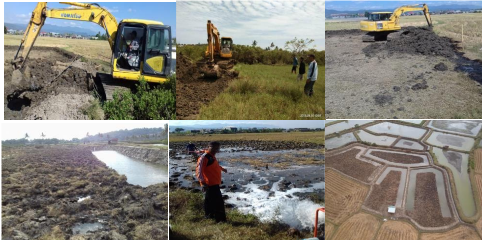
Gambar 5. Proses Rekonstruksi Lahan Menggunakan Ekskavator dilanjutkan dengan Pengolahan Menggunakan Hand Traktor
