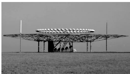
Gambar 2 Konfigurasi 49 Antena DVOR
