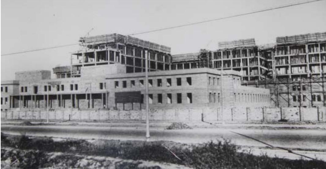
Vista de la estructura en ejecución en diciembre de 1949. En ella se aprecia el orden de ejecución de los trabajos: en primer lugar el ambulatorio, del que ya se habían realizado los cerramientos. (Fuente: archivo INGESA)
