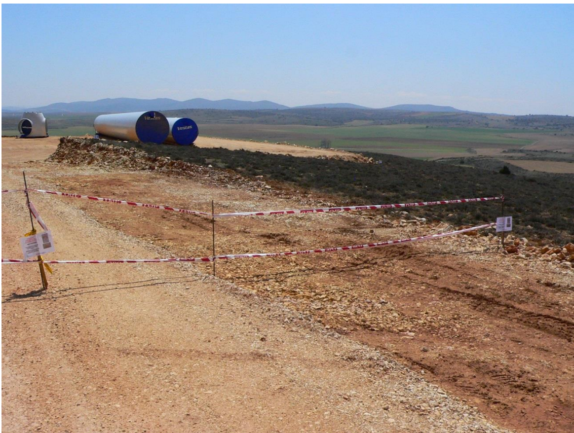
Figura 50. La instalación de parques eólicos implica una enorme degradación del matorral donde habita la alondra ricotí. En esta imagen se muestran las obras durante la construcción del parque eólico de Lomagorda (Tartanedo, Guadalajara). Autor: Carlos Talabante.
