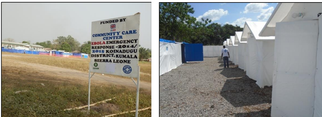
Figura 1 Izquierda: CCC en la escuela de Kumala. Derecha: obra de construcción del Centro de Kasumpe cerca de la capital Kabala.
