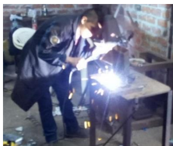
Figura 1-3: Soldadura de las platinas
