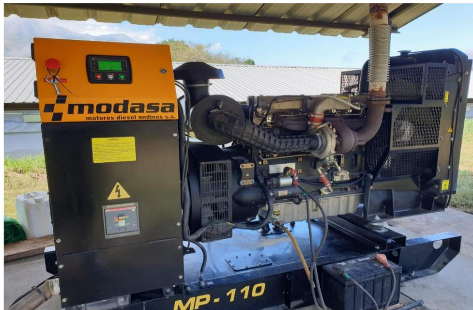
**Figura 3-3:** Grupo electrógeno tipo abierto
