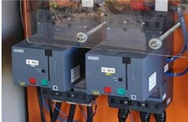
**Figura 8-3:** Accionamientos motorizados del interruptor
