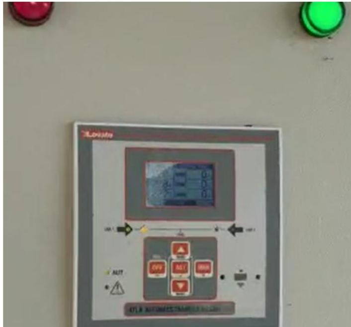
**Figura 5-4:** Energía de la red pública restablecida, generador apagado
