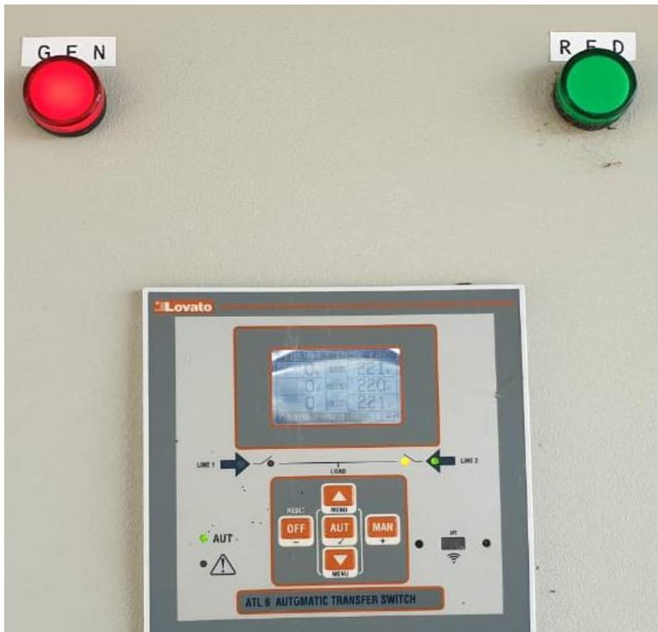
**Figura 1-4:** Luces indicadoras del tablero del Sistema de transferencia
