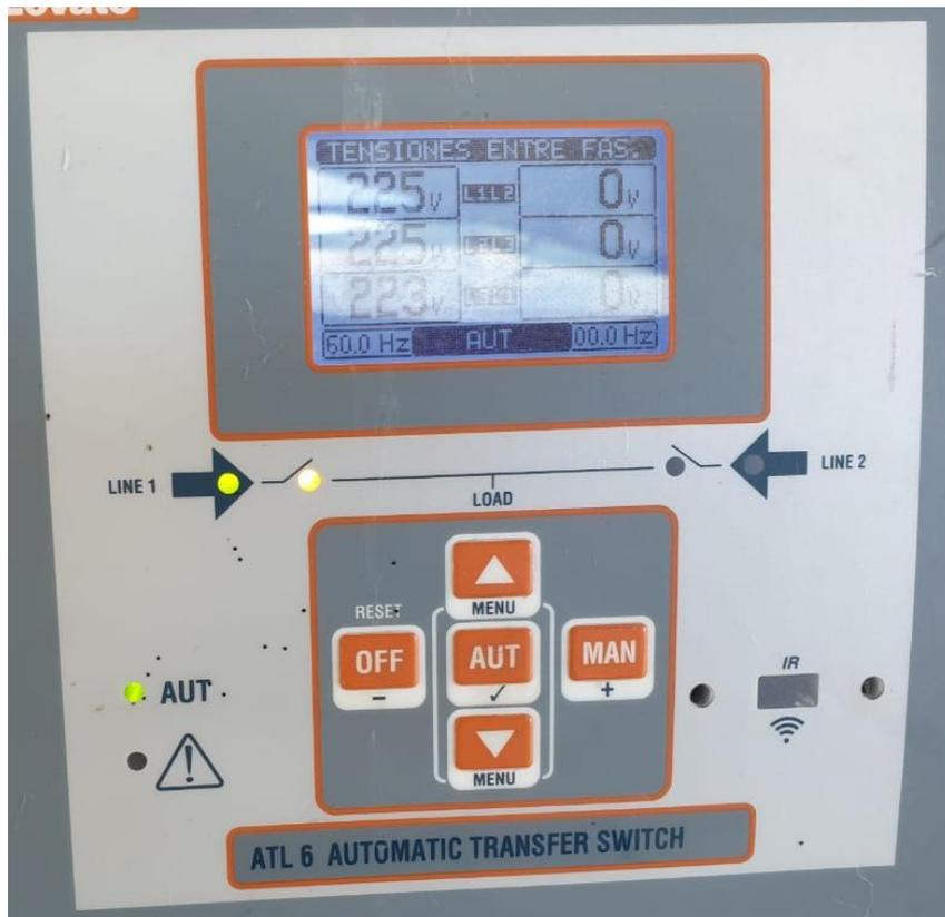
**Figura 6-4:** Línea 1 de la red encendida, tensión de la red línea a línea
