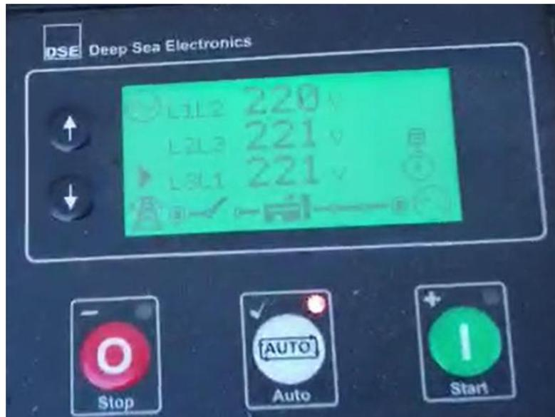
**Figura 3-4:** Voltaje línea - línea 220V del generador
