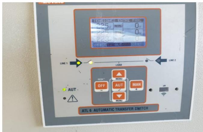
**Figura 9-5:** Dispositivo ATL 610 configurado
