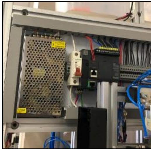
**Figura 57- 2:** Panel eléctrico de control.
