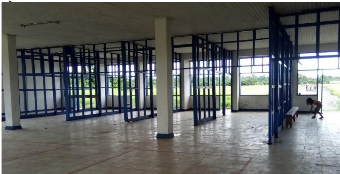
Figura 4.10. Vista interna de las instalaciones del aeródromo de Caballococha
