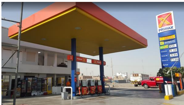
Figura 3.8. Estación de Servicios Cesars
