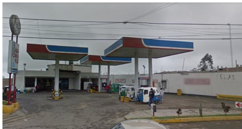
Figura 3.4. Gasolinera K & C – Panamericana Sur KM 80
