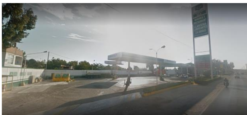
Figura 3.10. Estación de Servicios Petroperú
