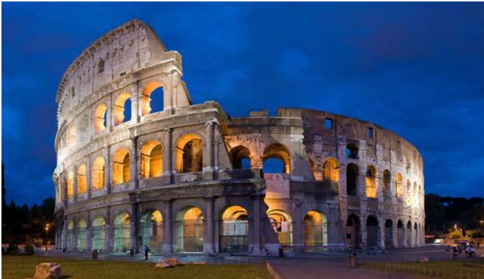
Figura 2. 1. Ejemplo de construcción con concreto de puzolana
