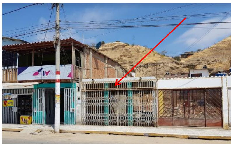
Figura 10.1 Imagen del local ubicado en Av. Piura N° 415
