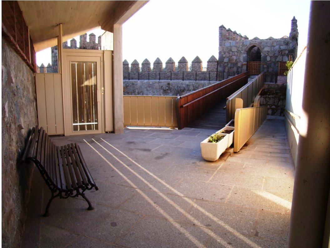
Imagen de la muralla de Ávila. Instalaciones Municipales. Fuente: Ayuntamiento de Ávila
