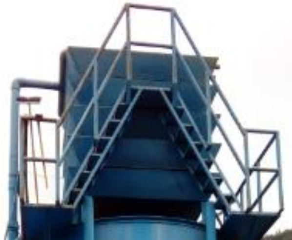
Figura 6. Bandejas de Aireación Sistema La Esmeralda
