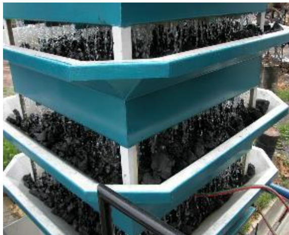
Figura 3. Bandejas de Aireación
