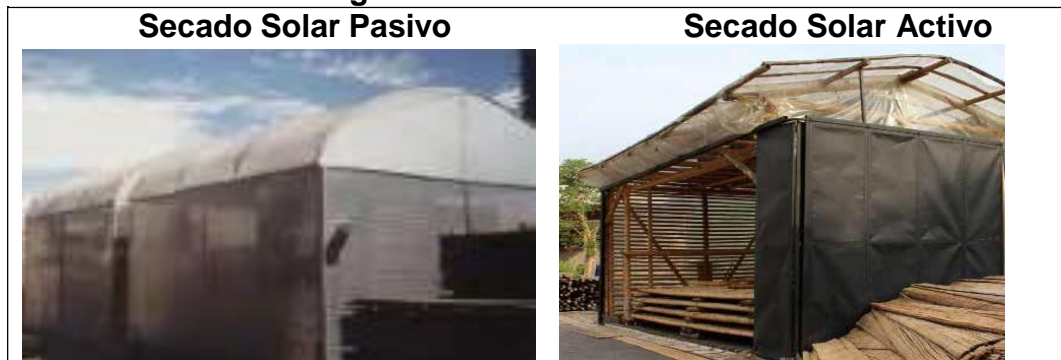
Figura 4. Solar de la Guadua
