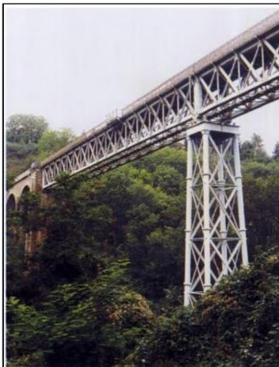
Figura 8. Gannat Francia, Viaducto de Neuvial
