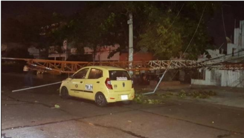
Figura 6. Torre colapsada, Barranquilla
