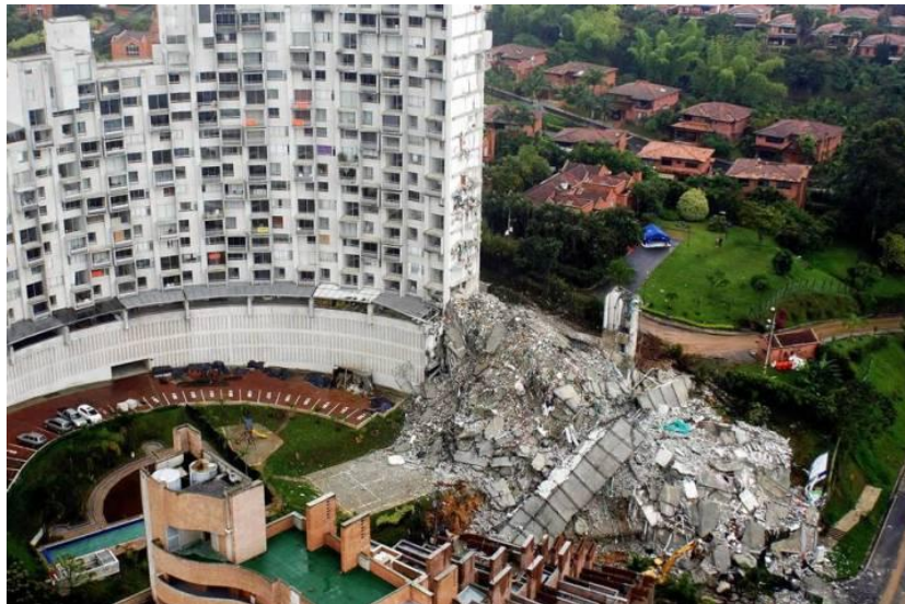
Imagen 24. Edificio Space – Medellín.
