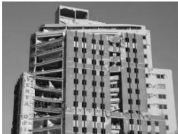
Imagen 9. Irregularidad estructural en planta y elevación-Chile.
