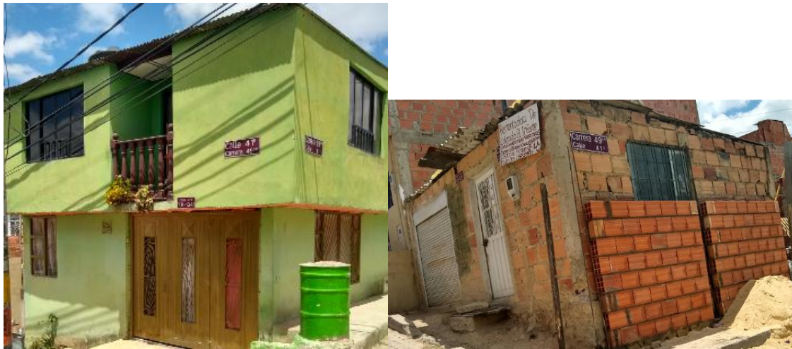
figura 6 Fachadas en el barrio. Fuente: Elaboración propia,2019.
