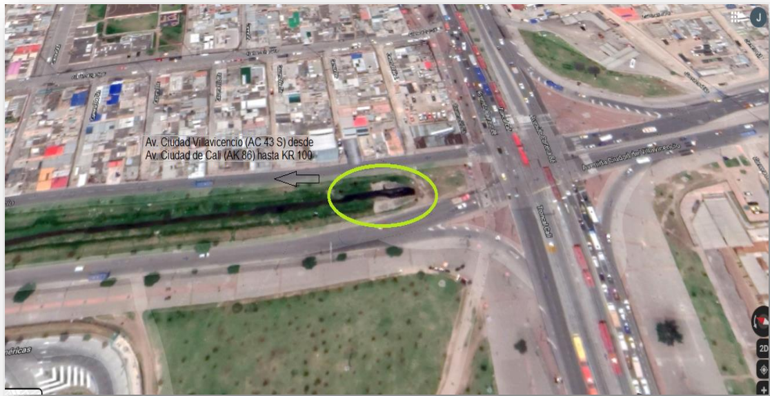
Figura 5. Intersección Canal Tintal II.
