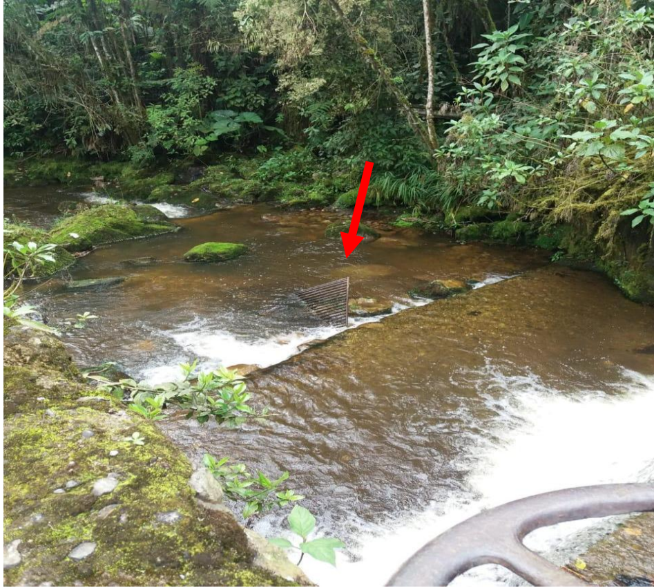
Imagen 14. Residuos de la Rejilla por Falta de Mantenimiento.
