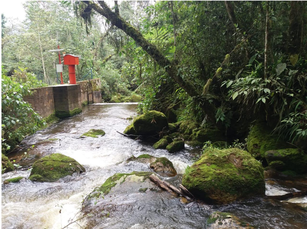
Imagen 15. Paredes de Contención de la Bocatoma.
