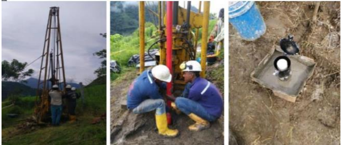
Imagen 69. Instalación inclinómetros en el Túnel Mulatos
