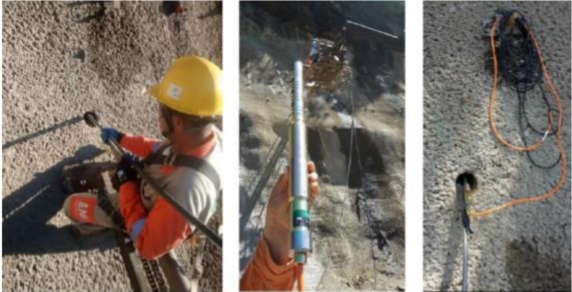
Imagen 68. Instalación de extensómetros, Túnel Mulatos
