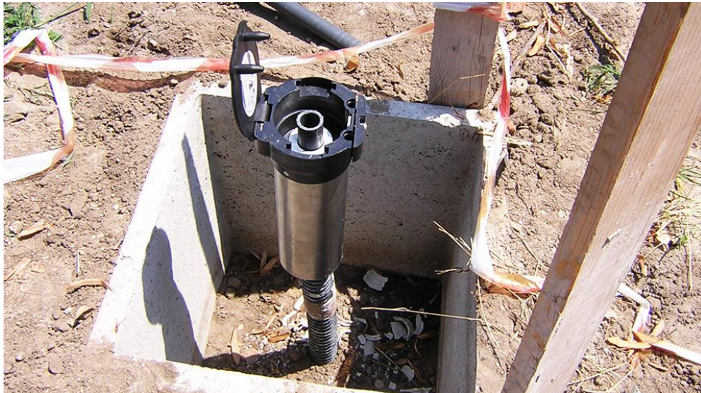
Imagen 33. Extensómetro Magnético.
