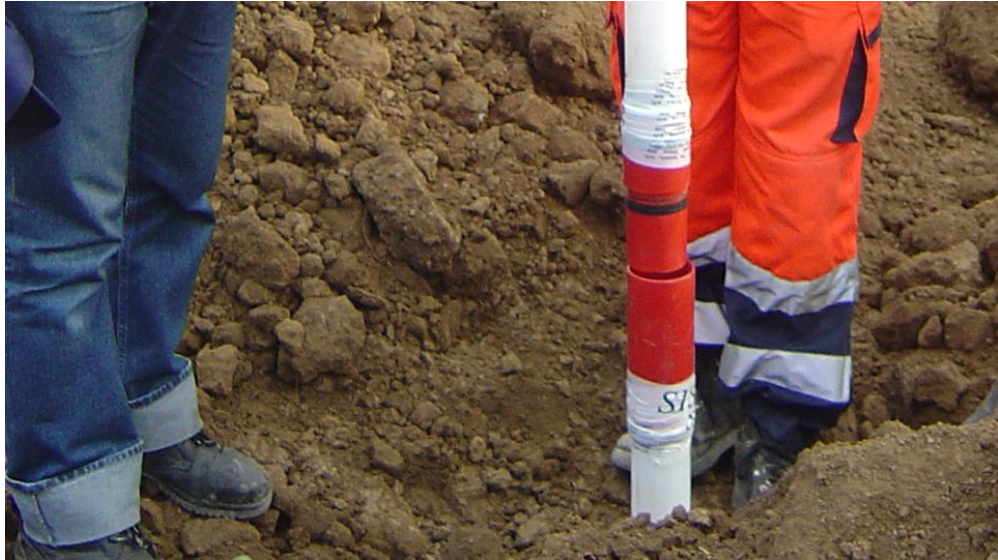
Imagen 22. Tubería Inclínométrica de junta rápida
