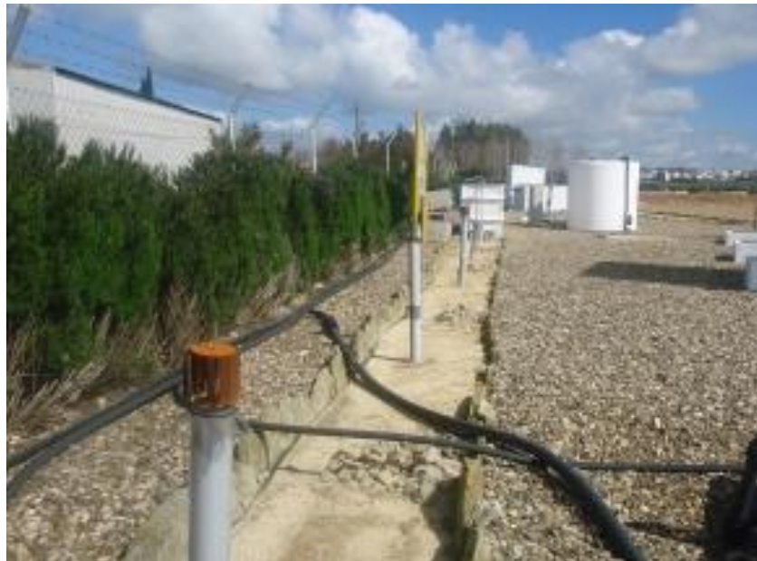
Imagen 42. Canal de saneamiento.
