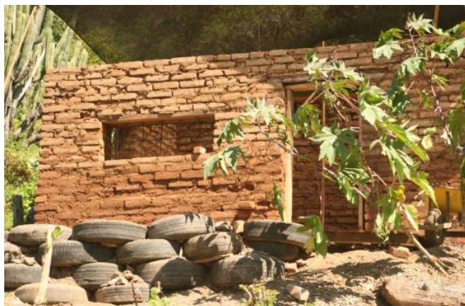
Imagen 45. Fachada de vivienda construida en adobe.
