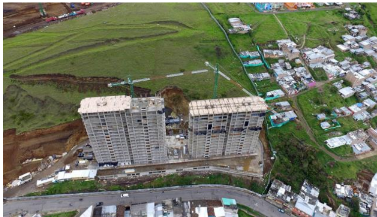
Imagen 20. Torres en proceso de construcción.
