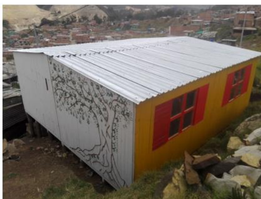
Imagen 46. Construcción de vivienda en madera-Techo Colombia.
