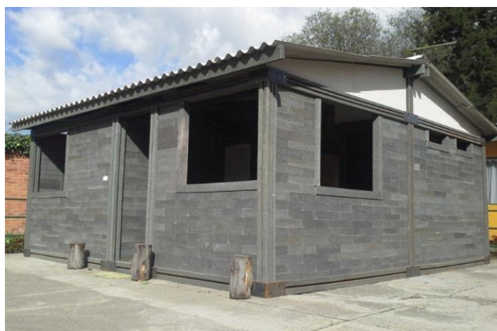
Imagen 47. Casa construida con ladrillos de plástico reciclado.
