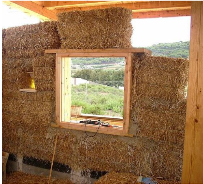
Imagen 44. Pacas de paja en construcción de vivienda.
