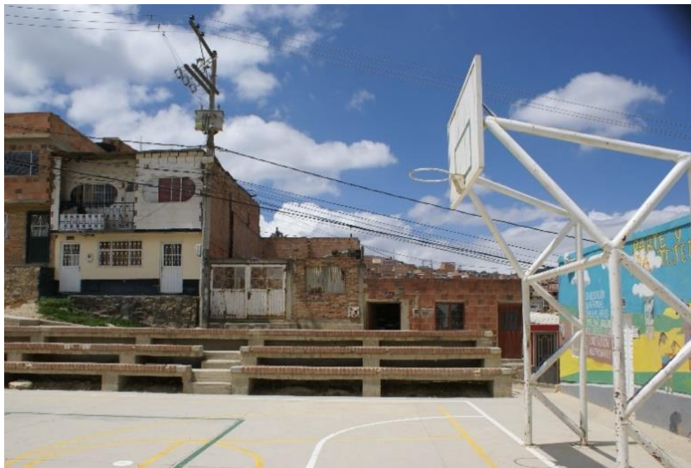
Figura 2: Cancha Central Bellavista Baja proyecto de Gas Natural, Fotografía: Autor.
