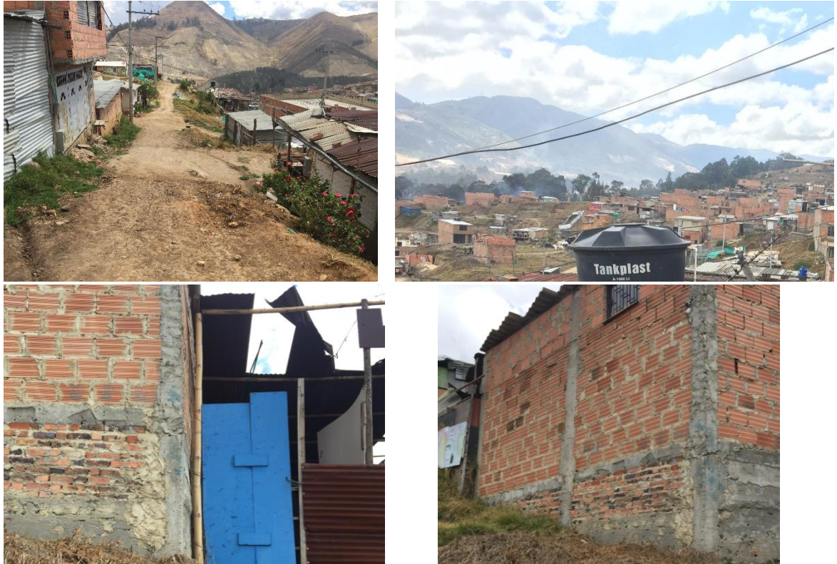
Figura 14. Registro fotográfico inspección estructuras del sector.
