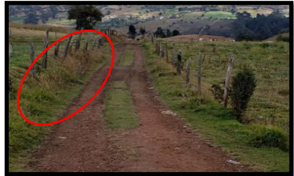
Fotografía 9 Punto Crítico 2-B
