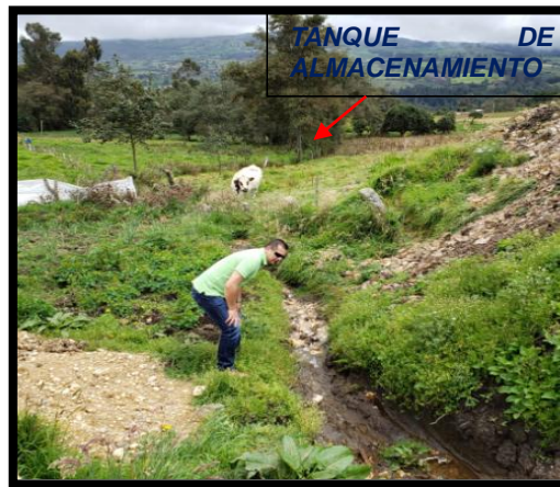
Fotografía 13 Punto Crítico 4-B
