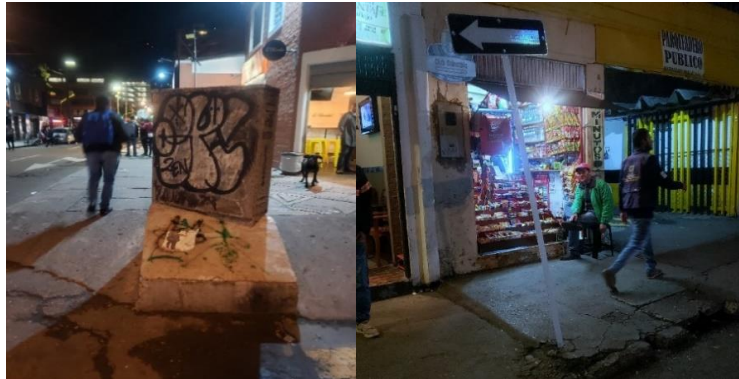
Ilustración 15 Estado de Andenes Calle 47.
