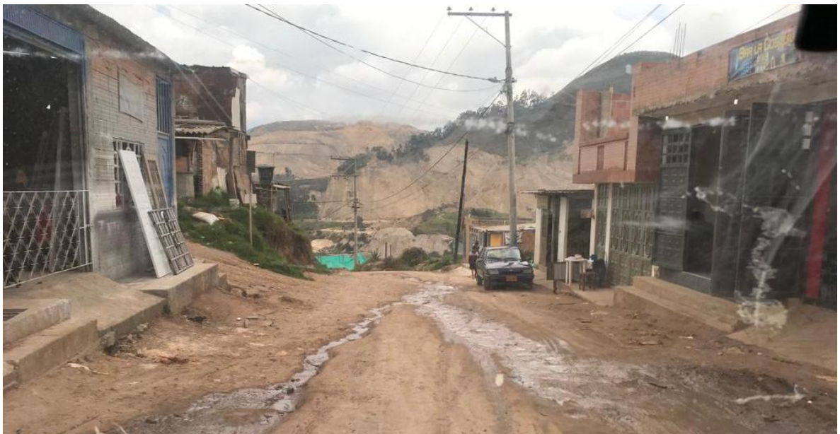
Figura 6. Manejo inadecuado de las aguas residuales en los sectores de la Vereda Panamá
