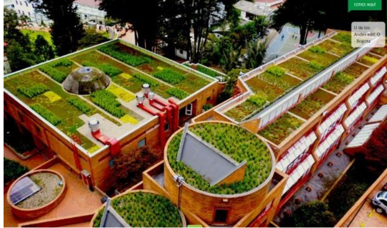
Figura 2-5. Techo Verde Groncol - Infraestructura Verde Fuente: http://www.groncol.com/home
