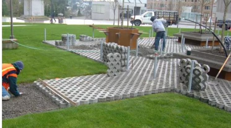
Figura 2-9. Superficie permeable adoquinada Fuente: http://sudsostenible.com
