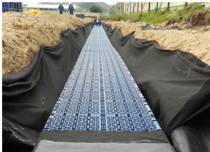
Figura 2-12. Tanque tormenta
