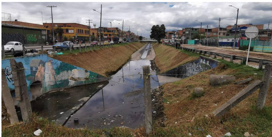
Figura 2-17. Canal de aguas lluvias de la calle 38 Sur Fuente: Autores
