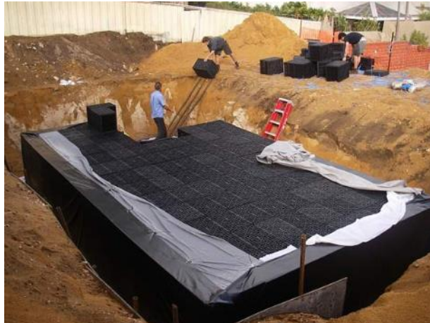
Figura 7 Instalación de tanques Aquacell, Fuente: (“5 sistemas para aprovechar el agua lluvia, 2017)
