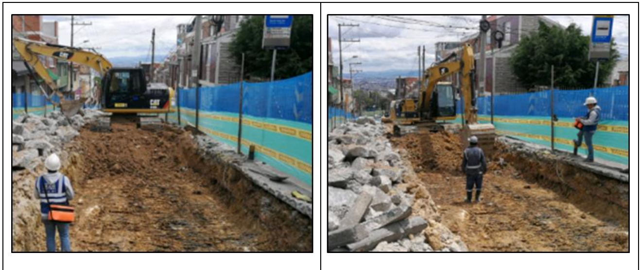
Foto 4-2 Subrasante Material Arcilloso
