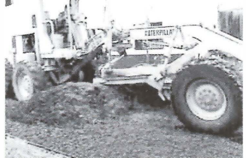
Fotografías 24 y 25. Aplicación de crudo y mezclado para homogeneización
