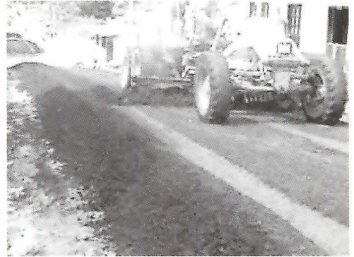
Fotografías 29 y 30. Definición de niveles y extendido de mezcla
