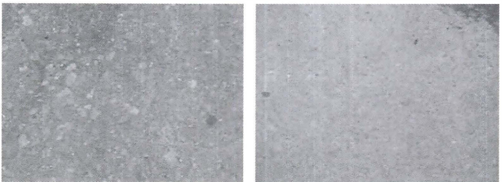
Fotografías 33 y 34. Aspecto superficial de las estructuras construidas.
