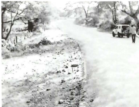
Fotografía 9 Aspecto final de base construida
