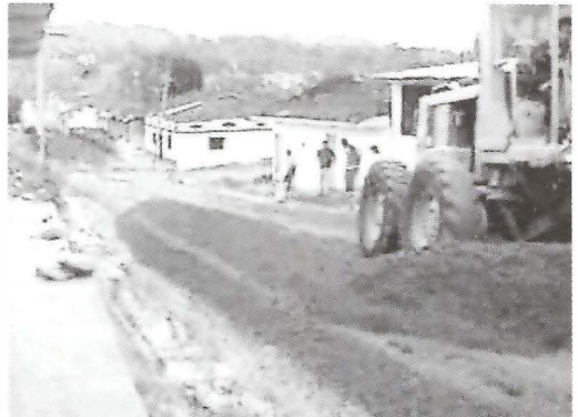
Fotografías 22 y 23. Aplicación de aditivo y homogenización de la masa
