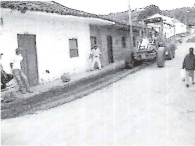
Fotografía 17. Preparación de sitio y conformación de cunetas
