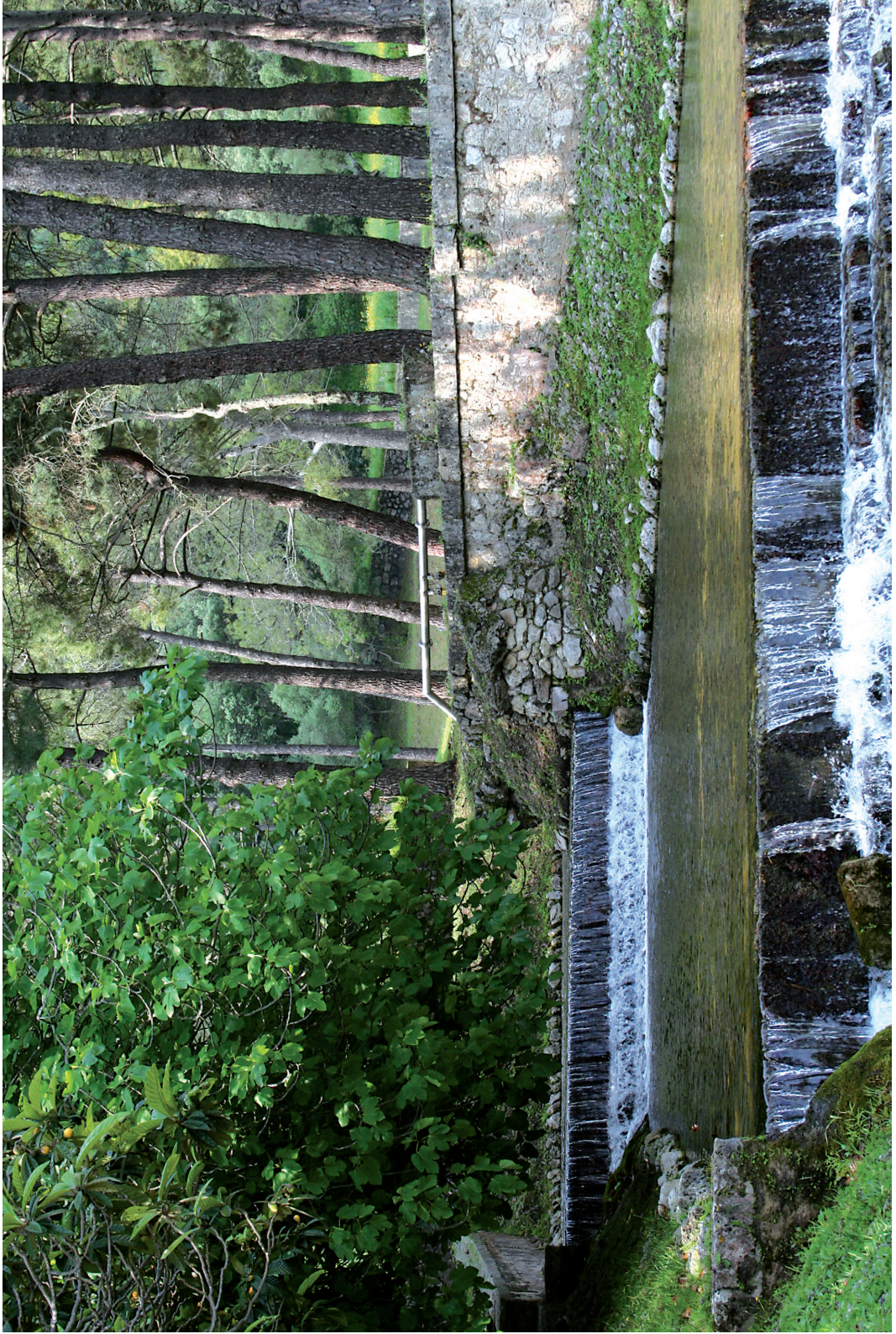
Manantial de Tempul. Detalle de la intervención de Ángel Mayo
