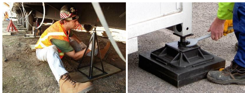
Figura 39: Ajuste de piezas estructurales en base de cimentación.
