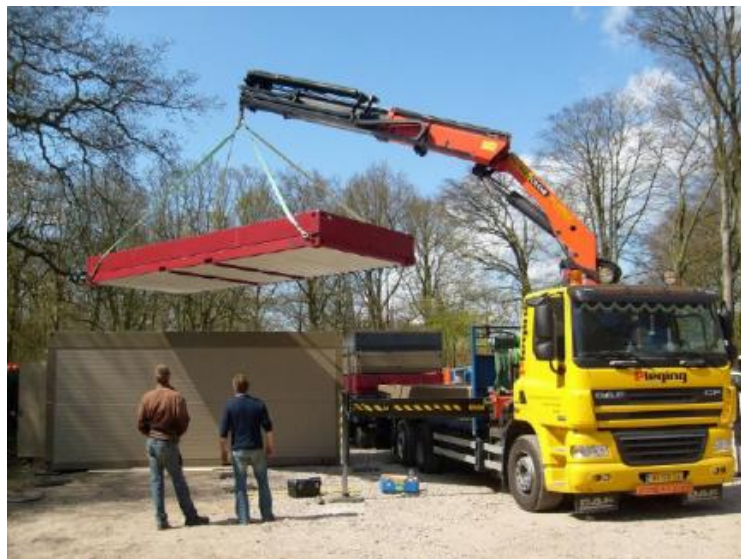
Figura 43: Construcción de modulo prefabricado y armado insitu por grúa.
