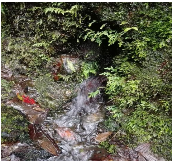
Imagen 3. Ventosa 3 ubicada 13 metros de la Bocatoma.
