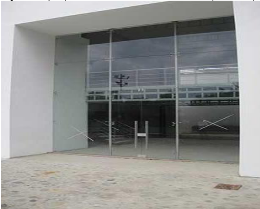
Figura 2. Ejemplo de una construcción realizado por la empresa
