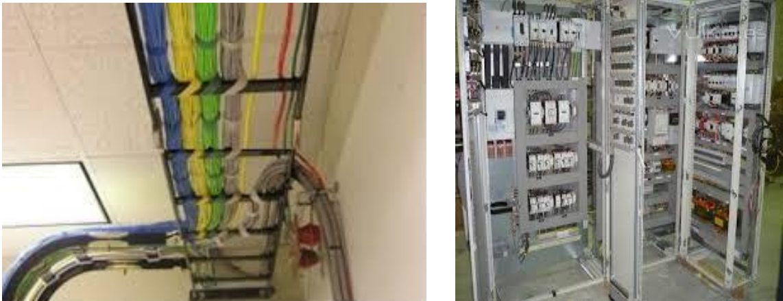
Figura 8. Instalación de tableros eléctricos industriales
