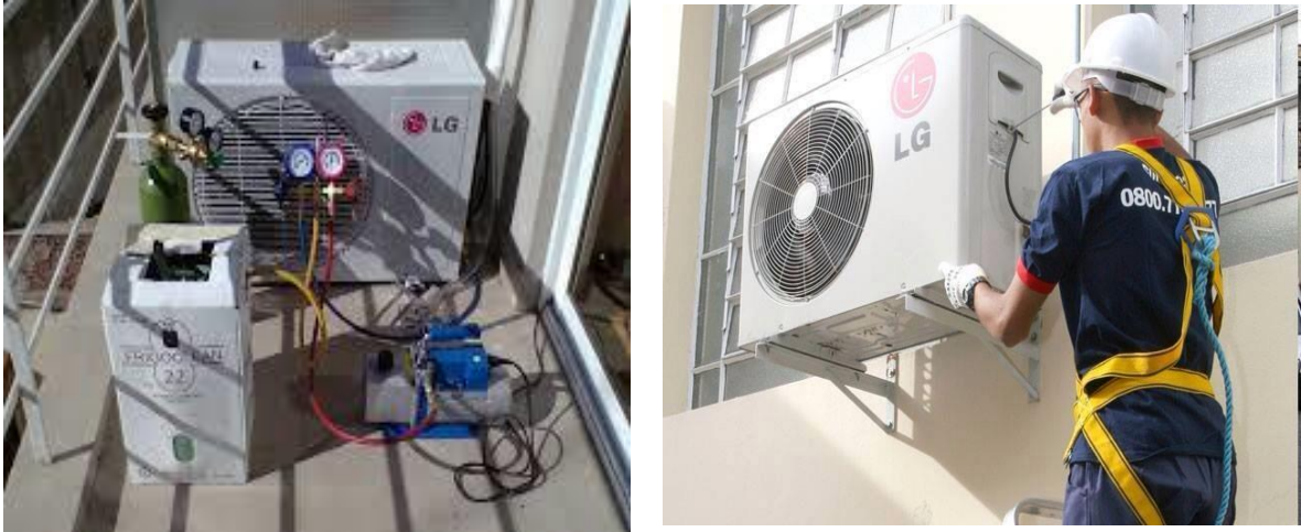
Figura 6. Instalación de aire acondicionado
