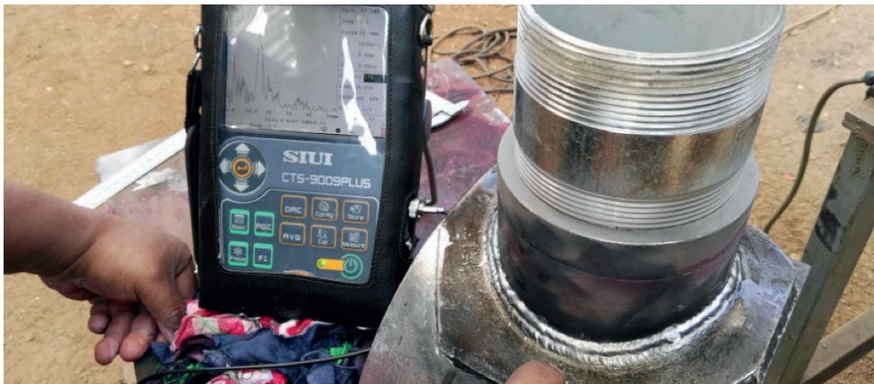
Figura 79. Aplicación de ultrasonido para evaluar calidad de la soldadura Tomado de [39]
