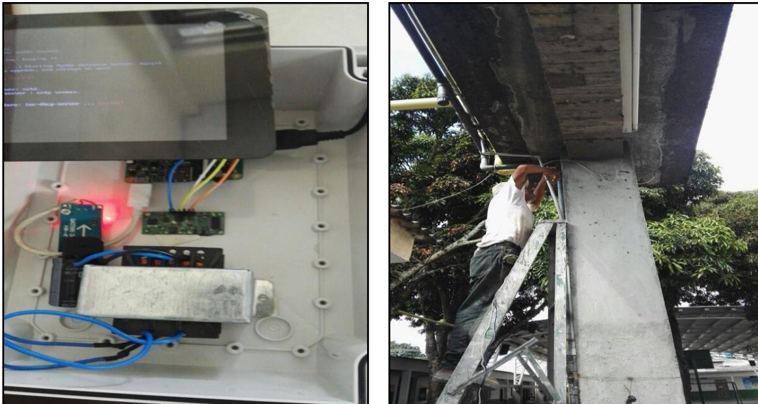
Ilustración 13 Instalación de sensores.
