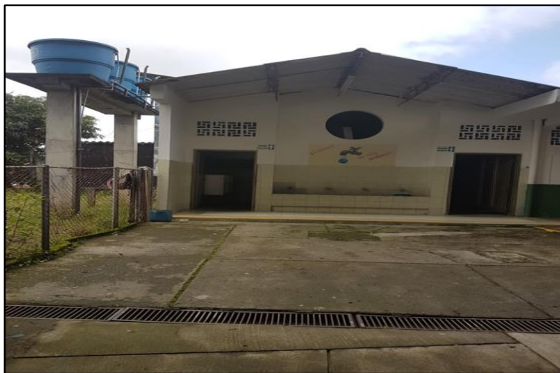
Ilustración 15 Baños de la Institución. Instalación del Sistema de Recolección de Aguas Lluvia.
