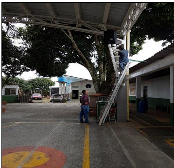
Ilustración 11 Instalación de la tubería.
