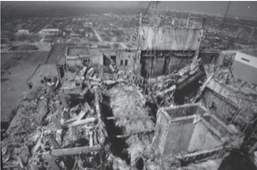
Figura 77. Imagen aérea de la planta de Chernóbil, posterior a la explosión [48]
